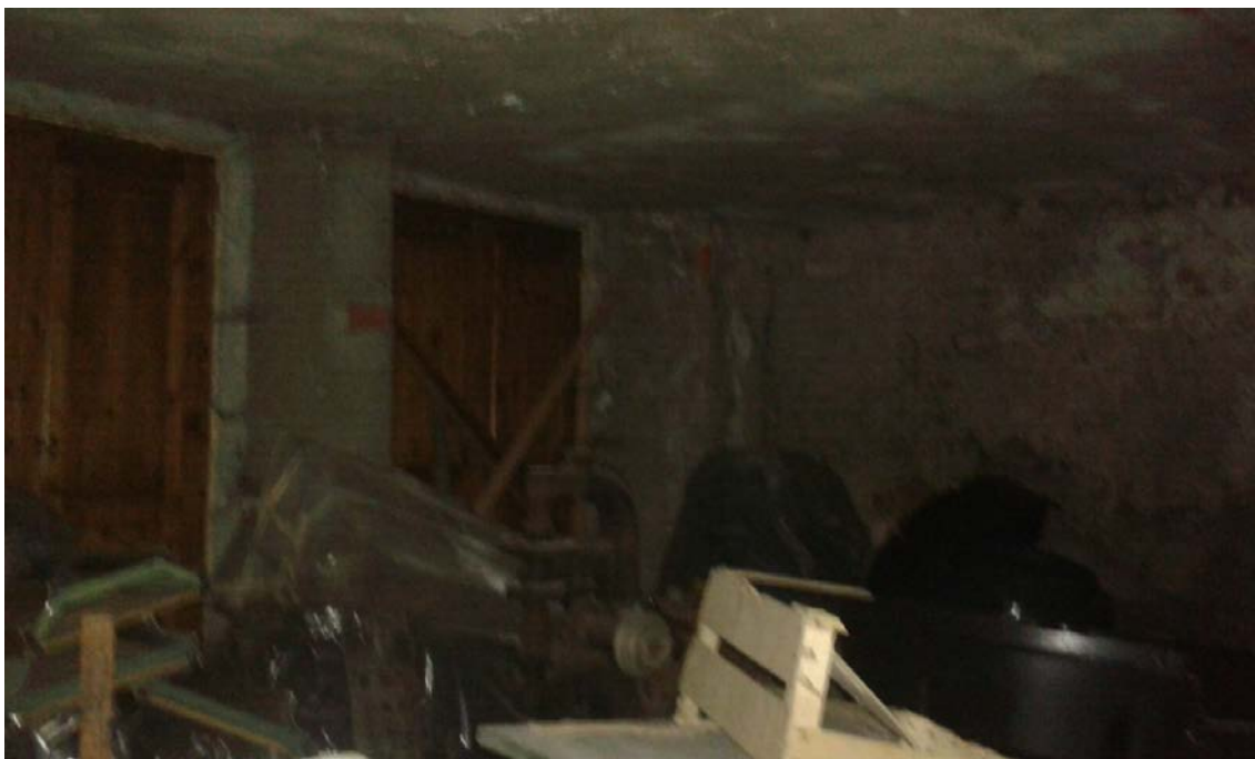
Il locale al piano terra
