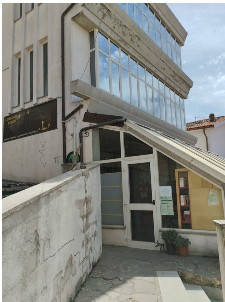
Figura 3 – Particolare dell'ingresso e della tipologia dei serramenti
