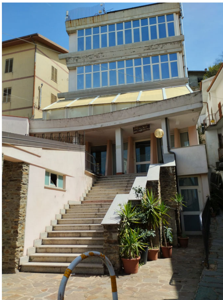
Figura 2 - Vista dall' esterno del fabbricato
