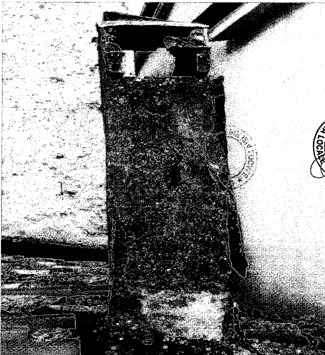
Foto n° 02 particolare del camino pericoloso visto dall'alto
